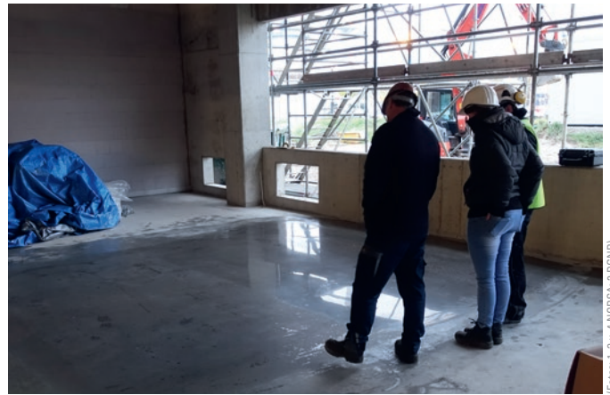
Bild 4 Testflächen auf dem zu vergütenden Betonboden vermitteln einen realistischen Eindruck vom Ergebnis. Individuelle Lösungen und Gestaltungsvarianten können so vor Ort begutachtet und festgelegt werden.
