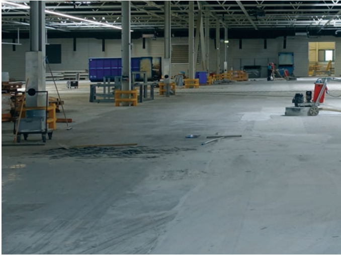
Bild 1 Am Produktionsstandort der Schweizer Firma Belimo in Großröhrsdorf wurde eine Produktionshalle umgenutzt: Bei diesem 20 Jahre alten Industrieboden (links) wurde zuerst eine Beschichtung mechanisch entfernt und anschließend der freigelegte Betonboden mit dem NORTEC® System nass geschliffen, chemisch verdichtet und auf den gewünschten Glanzgrad poliert (rechts).
