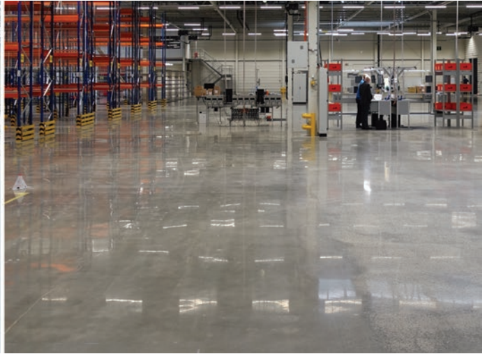
Bild 1 Am Produktionsstandort der Schweizer Firma Belimo in Großröhrsdorf wurde eine Produktionshalle umgenutzt: Bei diesem 20 Jahre alten Industrieboden (links) wurde zuerst eine Beschichtung mechanisch entfernt und anschließend der freigelegte Betonboden mit dem NORTEC® System nass geschliffen, chemisch verdichtet und auf den gewünschten Glanzgrad poliert (rechts).
