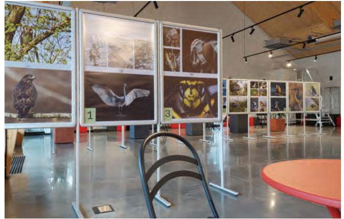
Bild 4 Dieser fachgerecht hergestellte polierte Betonboden in einem Zentrum für ökologische Bildung überzeugt weiterhin nach dreijähriger Nutzung trotz hohem Besucherverkehr.
