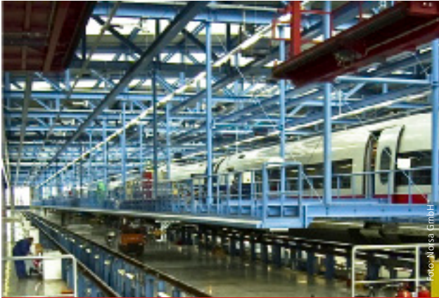
Deutsche Bahn, Wartungshalle
